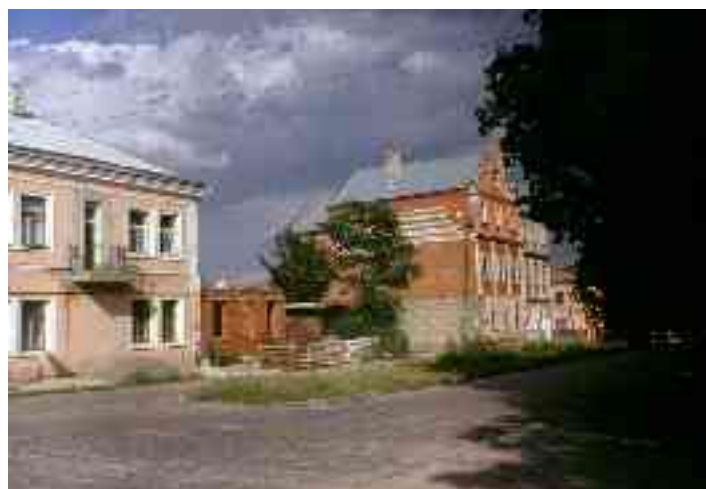
Weite Teile der Innenstadt sind sanierungsbedürftig
