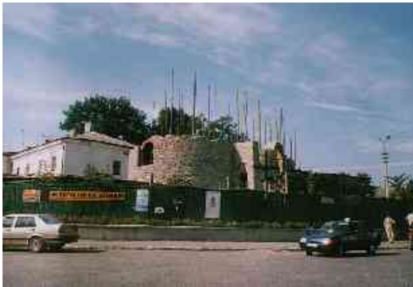
Die Trojizka Kirche wird derzeit wiederaufgebaut
