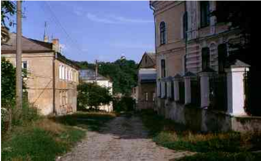
Ein Großteil der Seitenstraßen wirkt sehr ungepflegt
