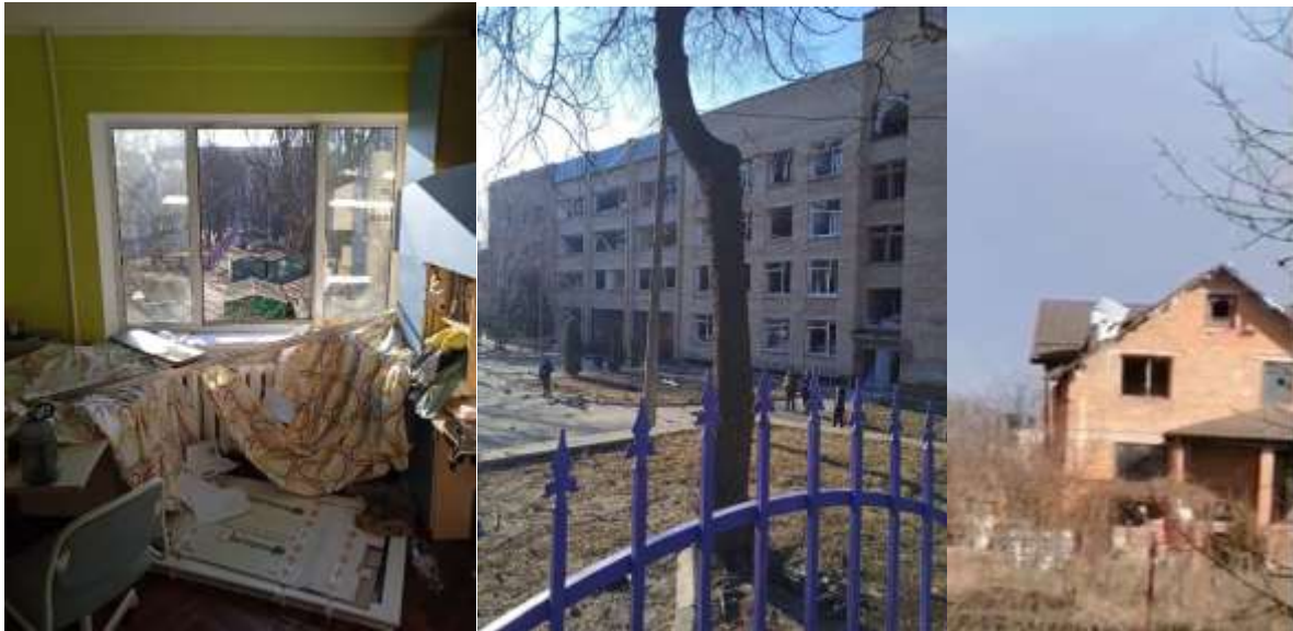
Zerstörte Schule, Wohnhäuser
